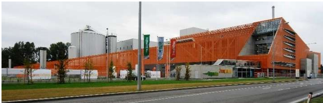
Figura 6. La planta de Pfaffenau, en Viena, Austria
