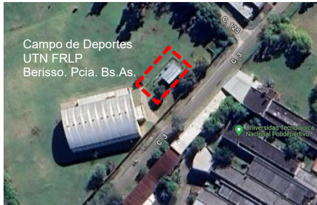
Figura 3. Ubicación de la Vivienda
