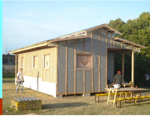
Figura 7. Imagen de la etapa de construcción
