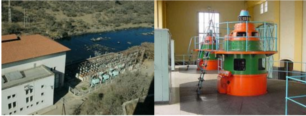
Figura 3. Central hidroeléctrica Cassaffousth. Fuente: EPEC
