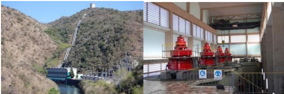
Figura 5. Central hidroeléctrica Los Molinos I. Fuente: EPEC
